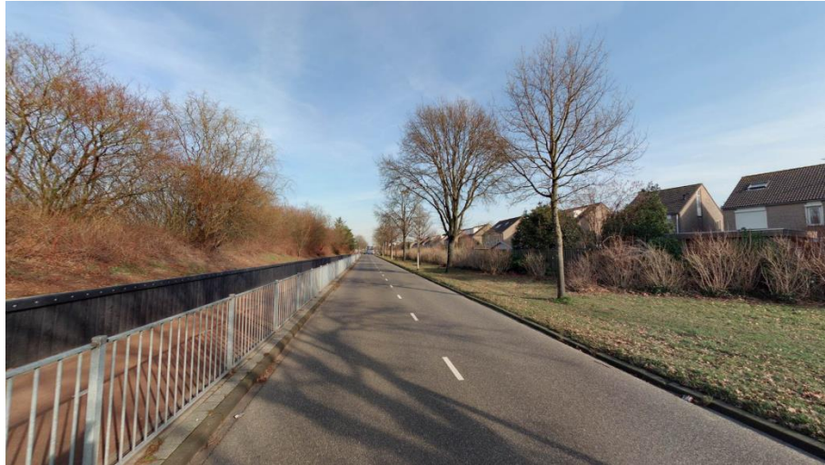
Figuur 5.14: Huidige situatie Thorbeckelaan (tussen Iepenbergring en Lariksberg) (bron: Google Maps).
